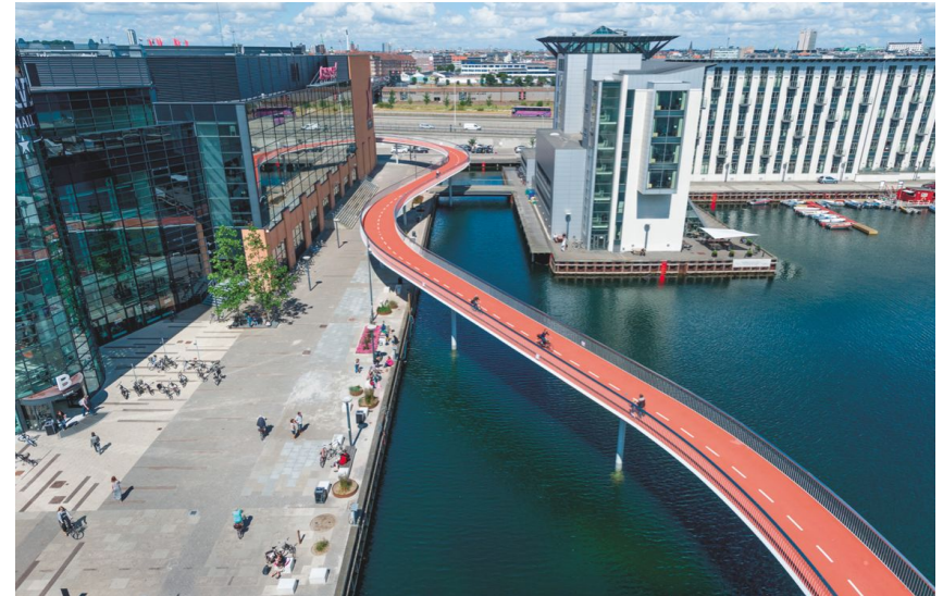
Une passerelle et cyclable entre le quartier de Fives et le centre de la ville , à l'image des nombreuses passerelles qui existent dans le monde, comme ici à Copenhague.
