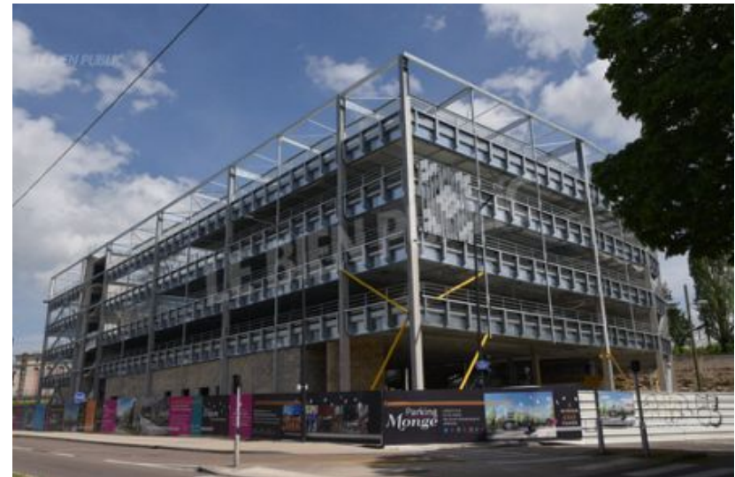
Création de parkings silo démontables "Smart-Parkings" en entrées du coeur de ville, desservis par les futures lignes de tram.
